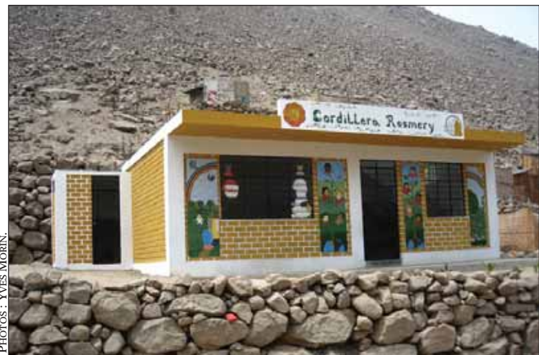
Yves Morin a construit une école dans le village de Nueve Octubre, à une quarantaine de minutes de Lima.
